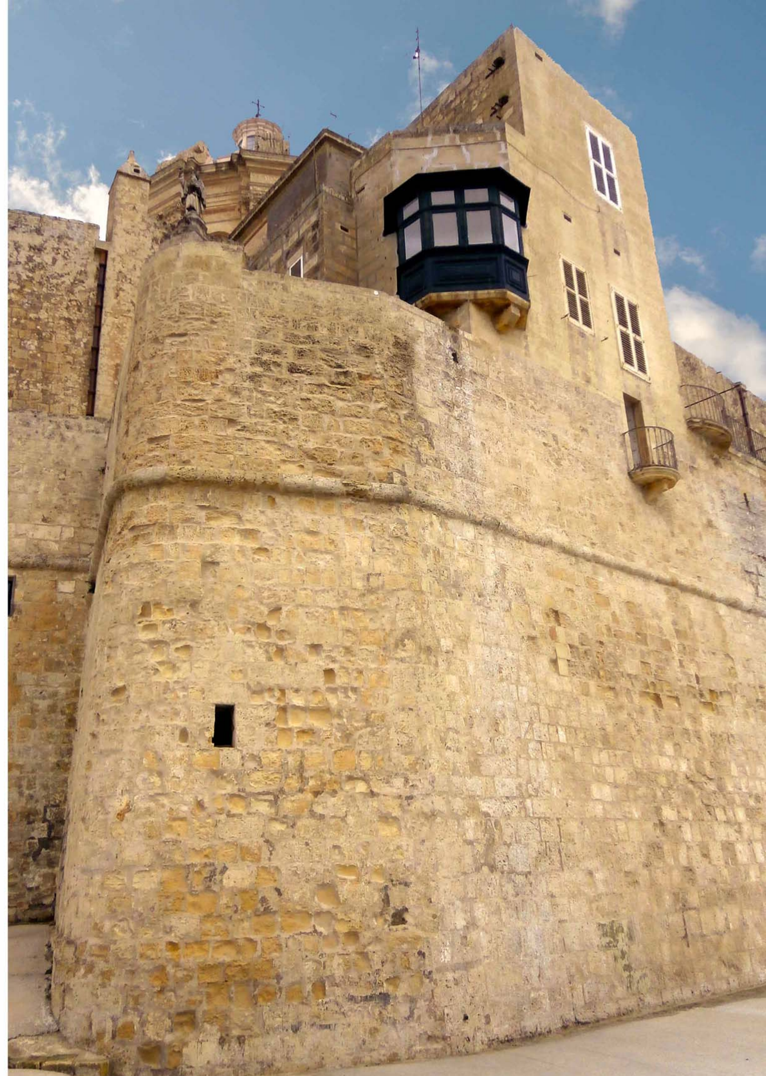
3 - Bastione Alto Despuig dopo i lavori
