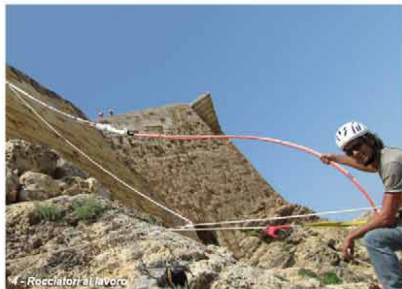
3 - Preparazione dell'attrezzatura per le chiodature della roccia
