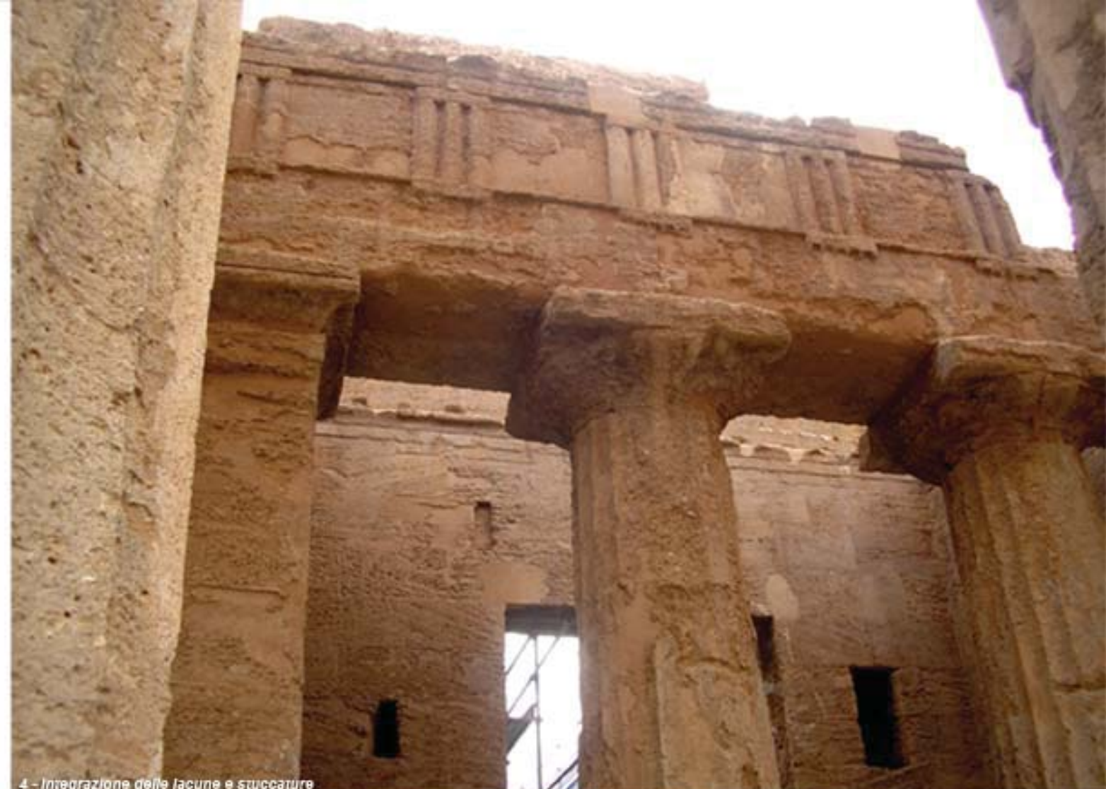
4 - Integrazione delle lacune e stuccature
