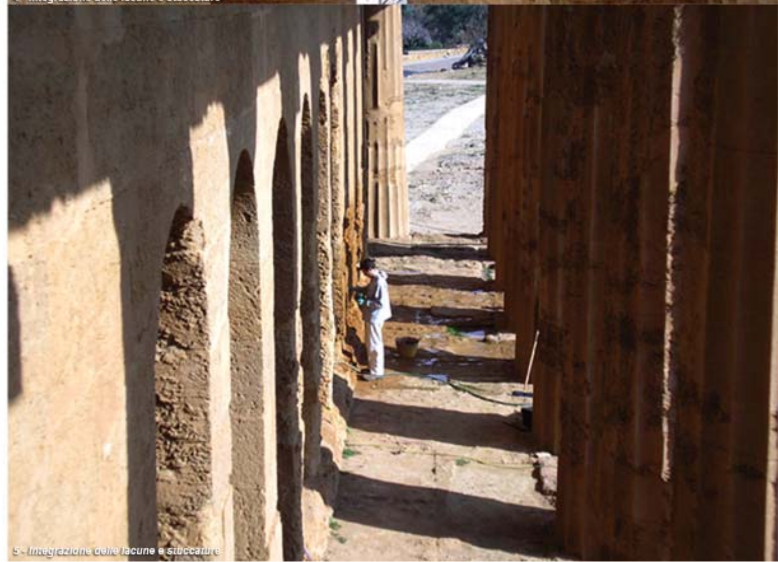
4 - Integrazione delle lacune e stuccature
