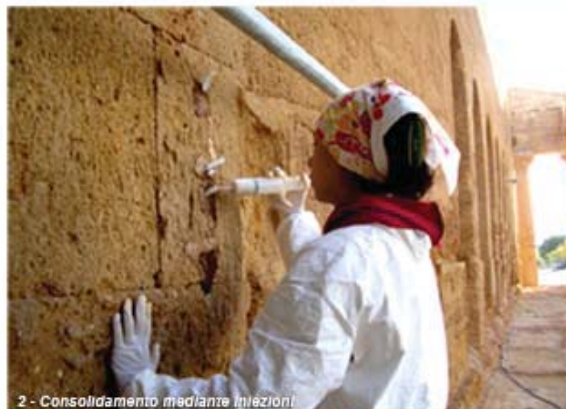
2 - Consolidamento mediante iniezioni
