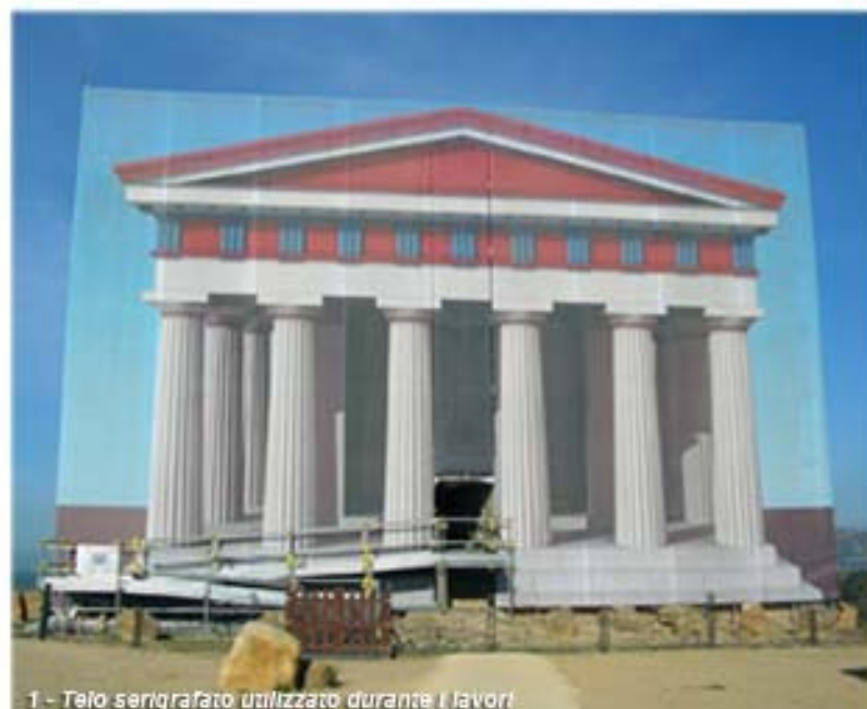
1 - Telo sarigrafato utilizzato durante i lavori
