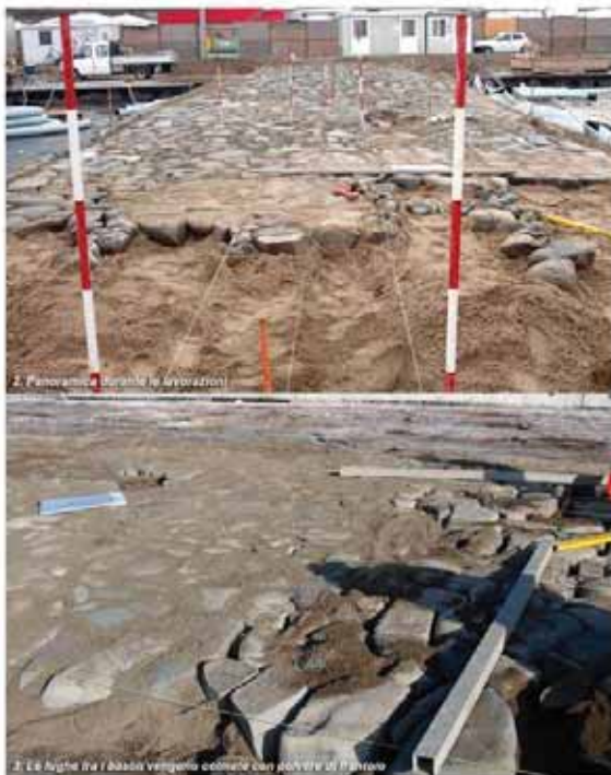
3. Le fughe tra i basoli vengono colmate con polvere di frantoio
