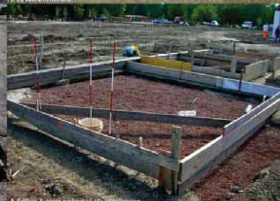
8. Edificio 1, fase preliminare alla ricostruzione
