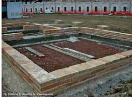
10. Edificio 1, durante la ricostruzione
